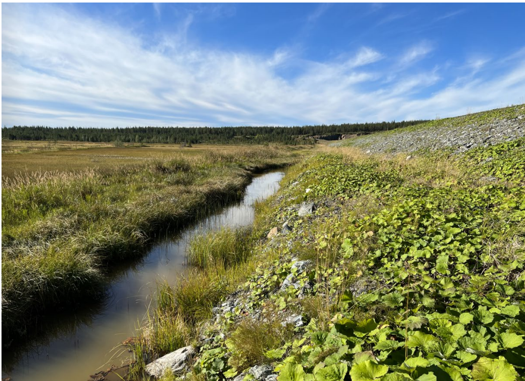
Kuva 9. Pato 2, selkeytsaltaan puoleinen luiska, kuva lounaaseen päin. Sama kohta kuin missä vaaleammat rikastushiekkakohdat havaittu.
