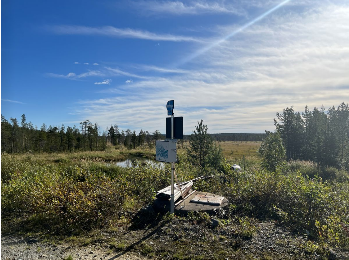
Kuva 24. Pato 3, padon sisäpuolen luiska
