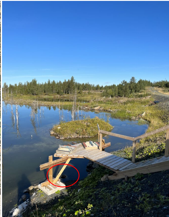
Kuva 12. Pato 2 laituri ja selkeytysaltaalle purettava vesi, purkukohta korostettu punaisella
