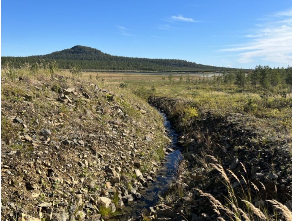
Kuva 20. Louhosvesien oja selkeytysaltaalle päin padon 2 jälkeen
