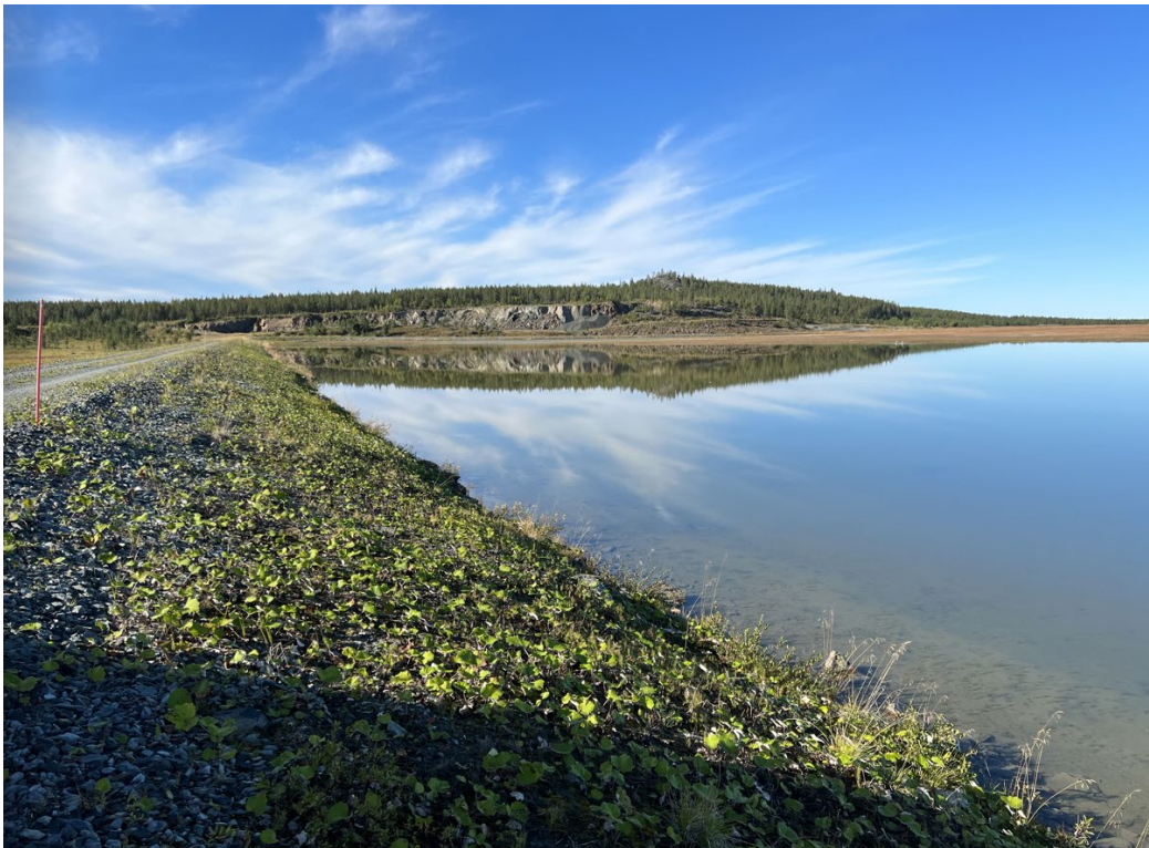
Kuva 7. Pato 2, rikastushiekka-altaan puoleinen luiska, kuva lounaaseen päin.
