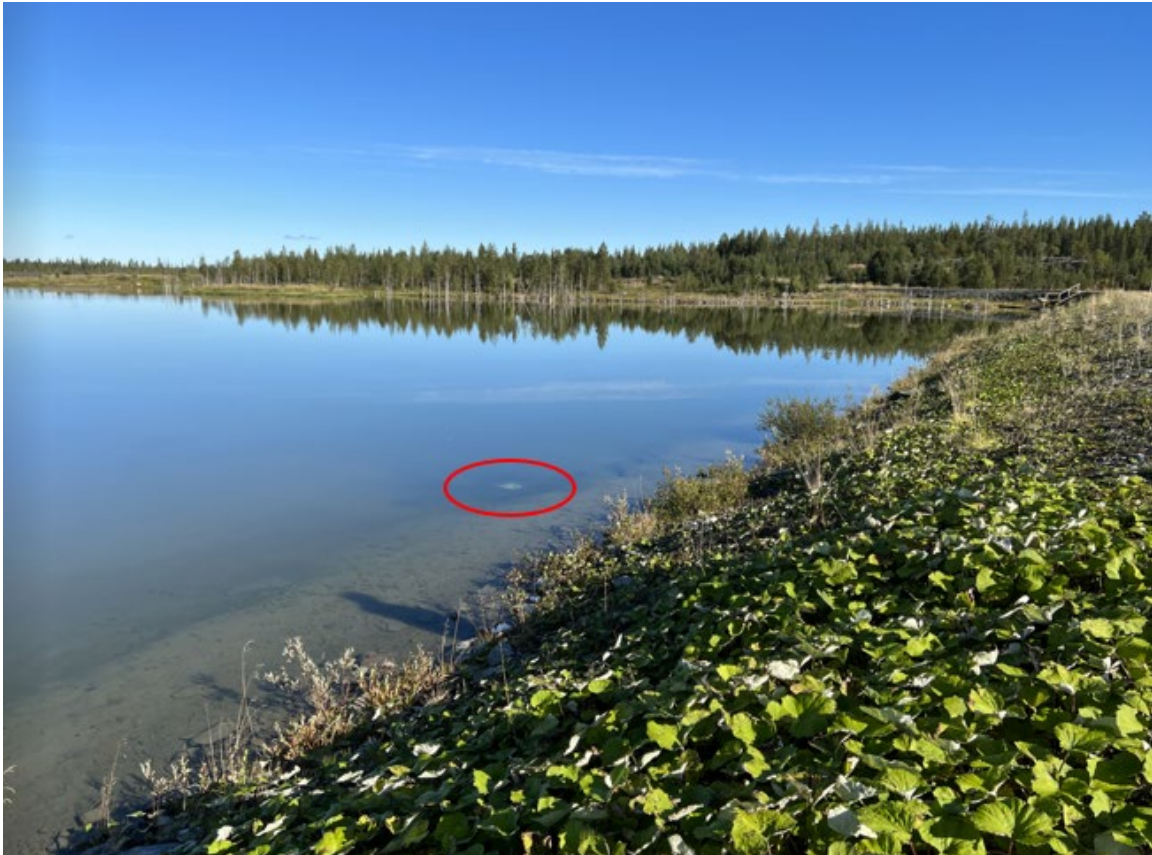
Kuva 5. Pato 2, rikastushiekka-altaan puoleinen luiska, kuva koilliseen päin. Punaisella korostettu havaittu vaaleampi kohta rikastushiekkan pinnassa. Kuva koilliseen päin.
