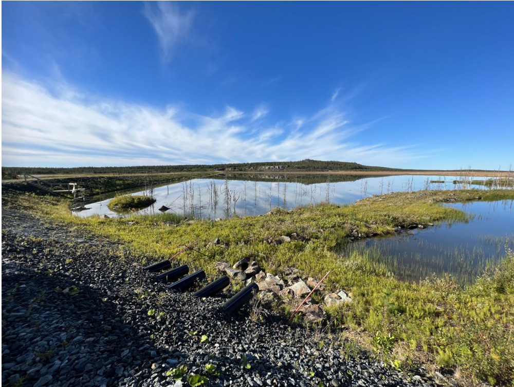
Kuva 13. Pato 2 ylivuotoputket (5 kpl) rikastushiekka-altaan puolella
