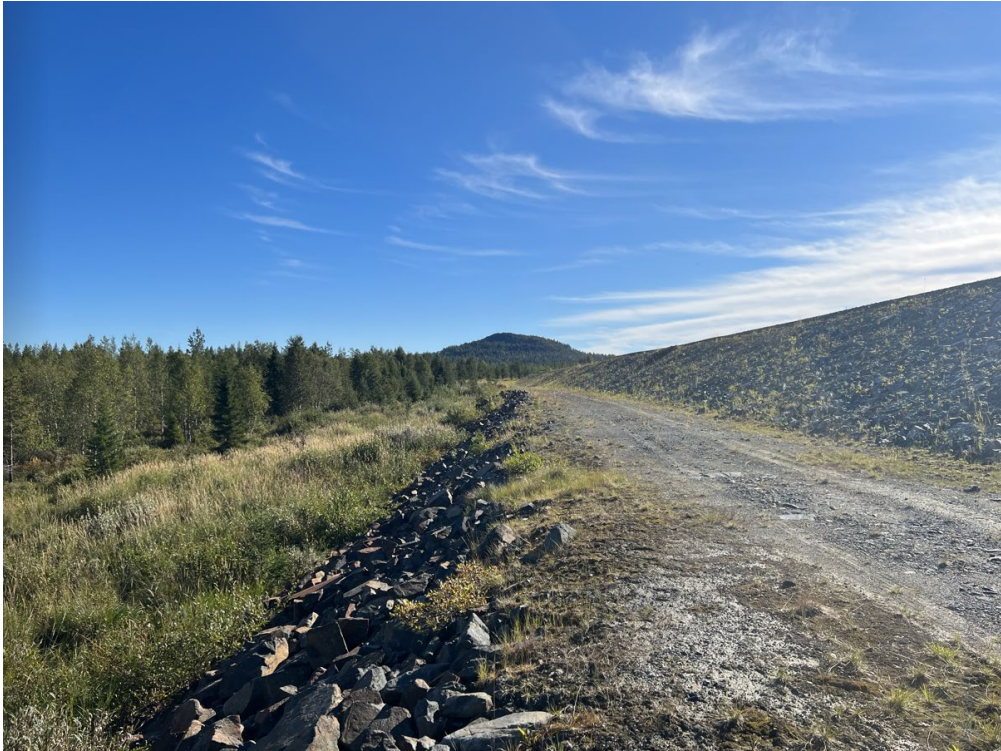
Kuva 15. Pato 1, padon ulkoluiska, kuva itään päin
