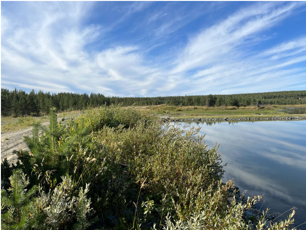
Kuva 22. Pato 3, padon sisäpuolen luiska, kuva lounaaseen
