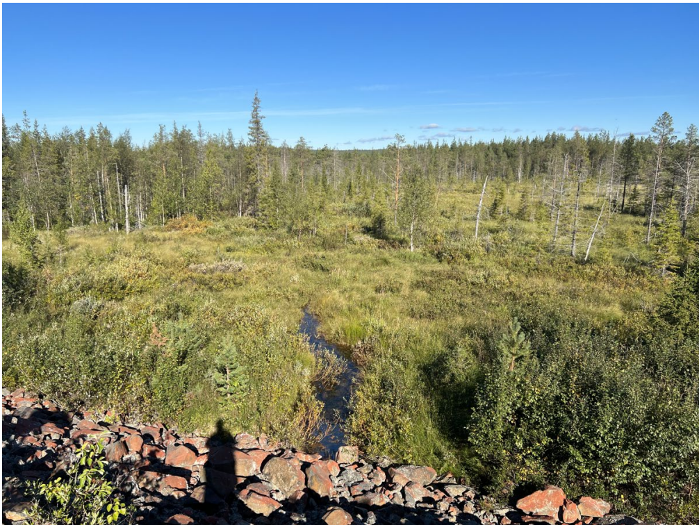
Kuva 16. Pato 1, padon ulkoluiska, kuva itään päin. Suotaumakohta padolta 1.
